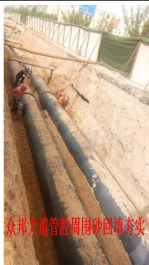
众邦大道管腔周围砂回填夯实
