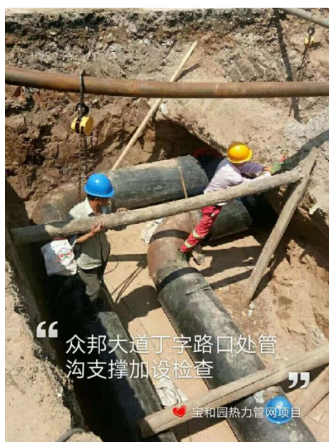
众邦大道丁字路口处支撑加设检查
