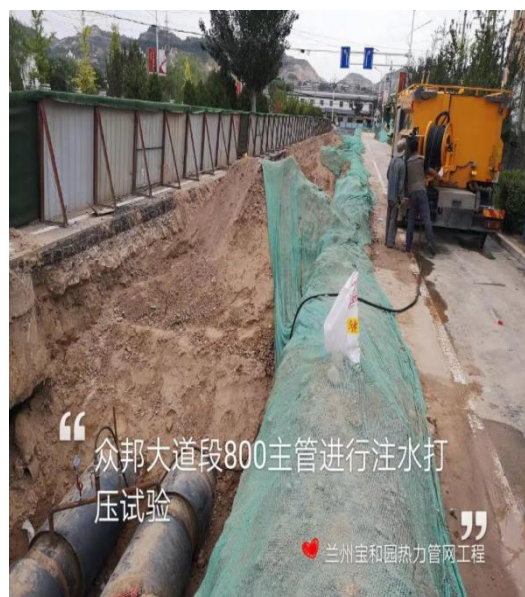
众邦大道段主管进行注水打压试验
